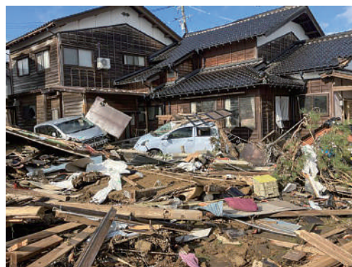
▲石川県珠洲市の被災の様子
